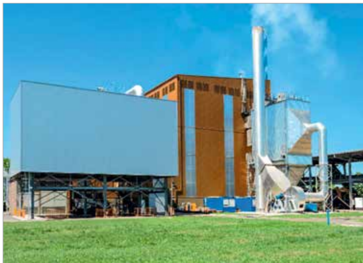
Котел для сжигания биомассы (отходов древесного производства), габаритный чертеж и фото
