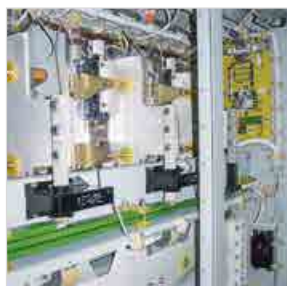
Силовая часть преобразователя ТРПЧ
