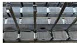
Установка уплотняющих клиньев
